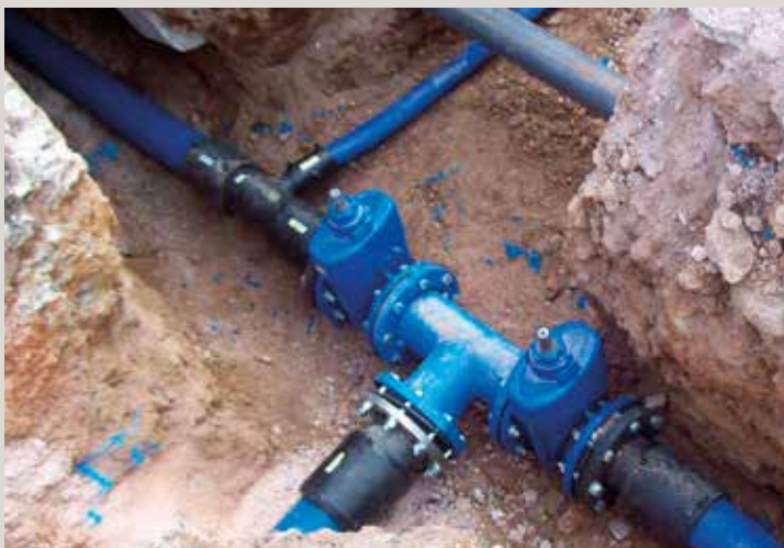
Κατάργηση παλαιού δικτύου ύδρευσης Βουτζά
